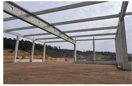
40m unterstützungsfreier Spannbeton
